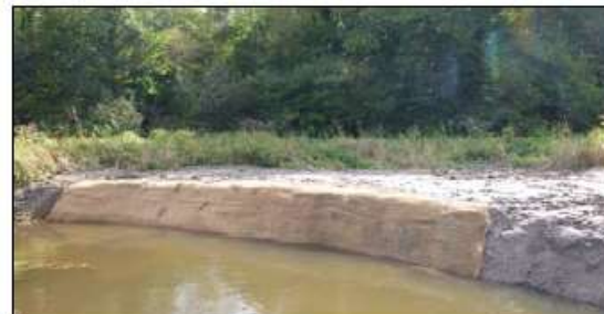
Protection des berges / Fermeture de l'ancien tracé par remblaiement et remise en état
