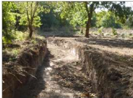
Renforcement du lit mineur par recharge de radier
